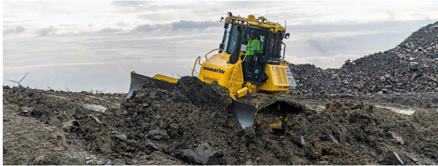
Die Planierraupe Komatsu1 D61PXi-24E0 ist mit einer einzigartigen automatisierten 3D-Maschinensteuerung ausgestattet.
