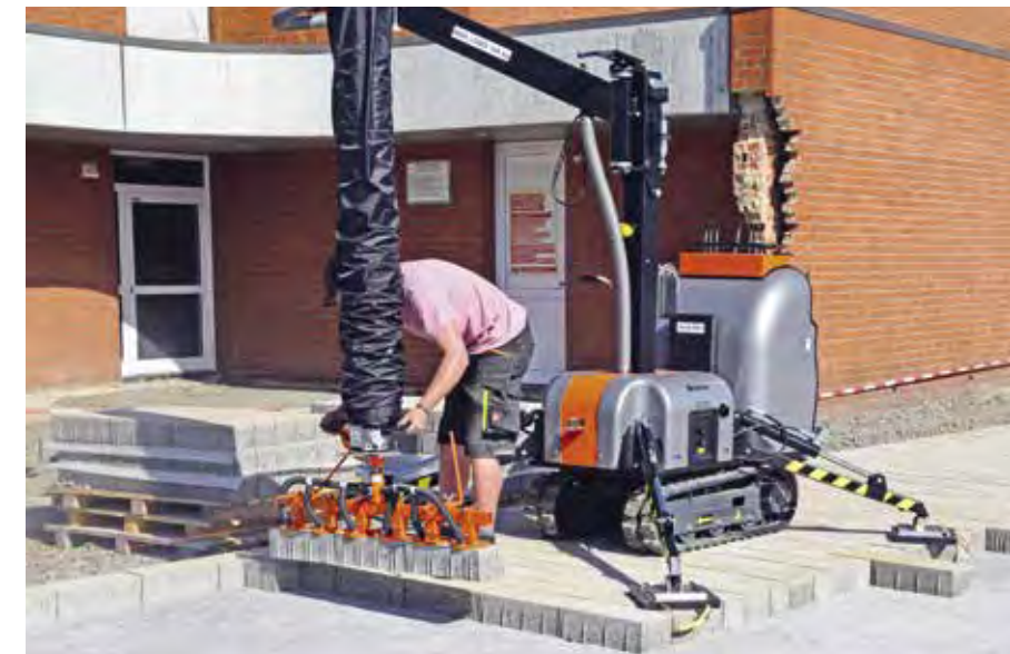
Zu sehen ist unter anderem der Optimas Vacu-Mobil-Allrounder, mit dem Beton- und Natursteinelemente bis zu 140 kg exakt und wirtschaftlich verlegt werden können.
