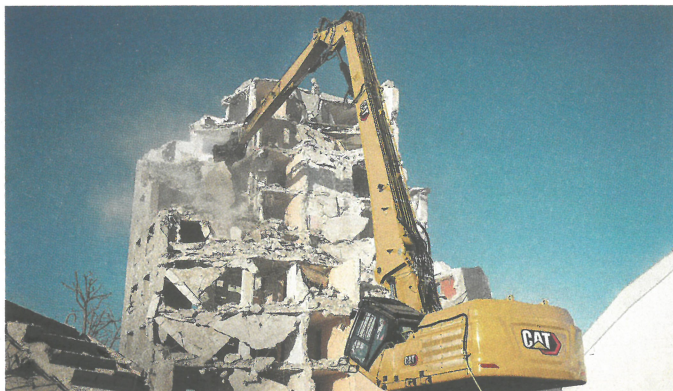
Der Abbruchbagger CAT 352 UHD ermöglicht eine Löffelbolzenhöhe von bis zu 28 Meter bei Arbeiten mit einem Arbeitsgerätegewicht von 3,7 Tonnen mit einer horizontalen Reichweite von 15,8 Meter
