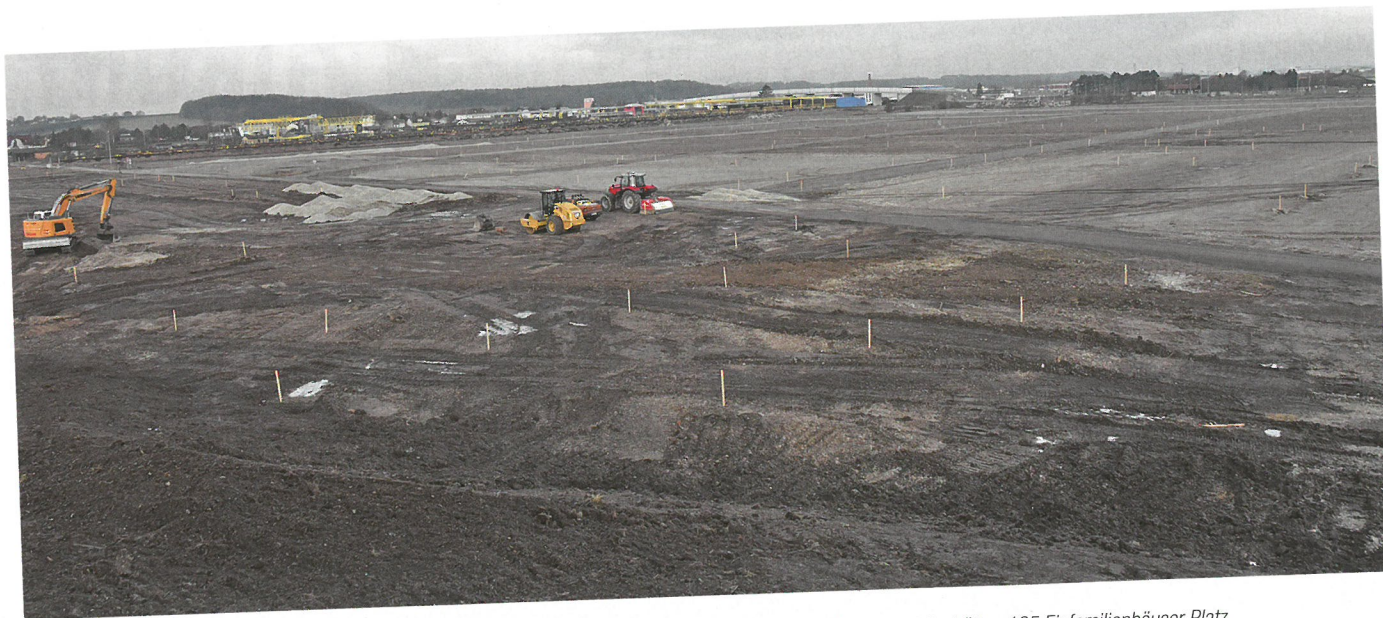
Die Vorarbeiten für die Befestigung des Geländes im NOE Central St. Pölten laufen auf Hochtouren. Auf dieser Fläche hätten 185 Einfamilienhäuser Platz.
